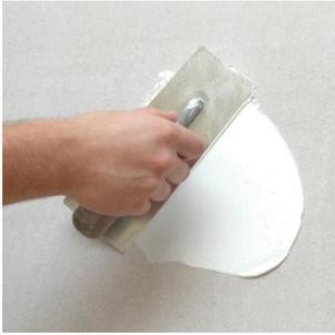
Первый слой покрытия наносится кельмой равномерным слоем не более 1 мм.
