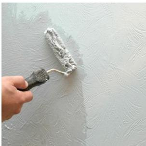
После полного высыхания краски наносится финиш-лак меховым валиком слоем до 1 мм. Во избежание образования стыков необходимо наносить финишное покрытие на всю обрабатываемую поверхность сразу, от угла до угла.
