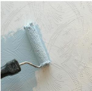
Затем на высохшую поверхность меховым валиком наносится колерованная краска.
