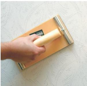
После полного высыхания слоя, поверхность шлифуется для удаления гребешков, «задигов» и неровностей с помощью шлифовальной терки (размер зерна 12-16). Возможную пыль удалить щеткой.
