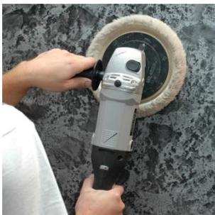
После подсыхания воска необходимо приступить к его полировке с помощью полировальной машинки с насадкой из мягкого неполосящего материала. Ориентировочное время высыхания финишного покрытия - 1 час (воск не должен прилипнуть к рукам, но при этом нельзя дать ему пересохнуть). Максимальная скорость – 2000-3000 оборотов/мин.
