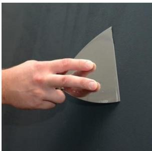
Через 1-2 часа необходимо обработать поверхность шпателем 15 см методом «железнения» для придания глянца поверхности и проявления рисунка.
