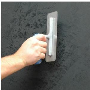
Через 1-2 часа необходимо обработать поверхность кельмой методом «железнения».
