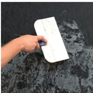
Далее на покрытие наносится заколерованный воск Optimist-Elite для проявления рисунка и придания поверхности серебристого перелива.
