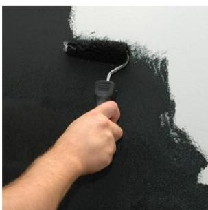
Первый слой материала накатывается меховым валиком разнонаправленными движениями тонким слоем.
