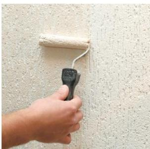
Затем меховым валиком нанести заколерованную краску «Оптимист» ровным тонким слоем на высохшую поверхность покрытия, не прокрашивая углубления рисунка.
