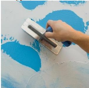
Материал наносится с помощью кельмы из нержавеющей стали. На небольшой участок поверхности до 1 м<sup>2</sup> нанести один цвет неровными хаотичными мазками.
