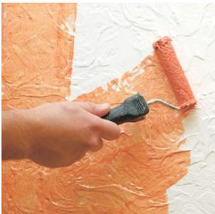
Колерованный лессирующий перламутровый состав наносится на готовую поверхность меховым валиком. Во избежание образования стыков необходимо наносить финишное покрытие на всю обрабатываемую поверхность сразу, от угла до угла.
