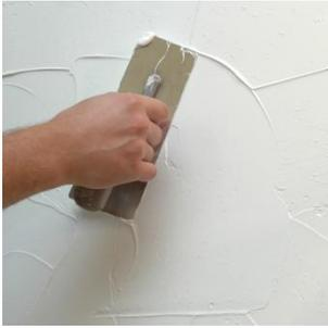
Базовый слой покрытия наносится кельмой равномерным слоем до 2 мм.
