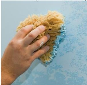
Второй слой наносится с помощью натуральной морской губки. Необходимо взять небольшое количество материала на губку и наносить его на стену. После каждого макания губки в ведро необходимо после каждого макания губки в ведро. Наносится штукатурка методом «тампонирования» участками до 1 м<sup>2</sup>.
