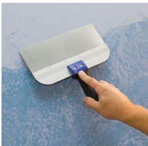
После полного высыхания второго слоя, наносится колерованный воск с помощью широкого шпателя для проявления фактуры.
