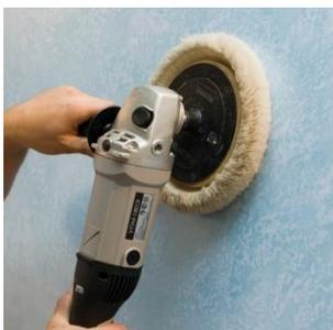
После подсыхания воска необходимо приступить к его полировке с помощью полировальной машинки с насадкой из мягкого меха. При слишком быстрых оборотах воск может подгорать. Полирование производится до тех пор, пока не будет получена равномерная глянцевая поверхность.
